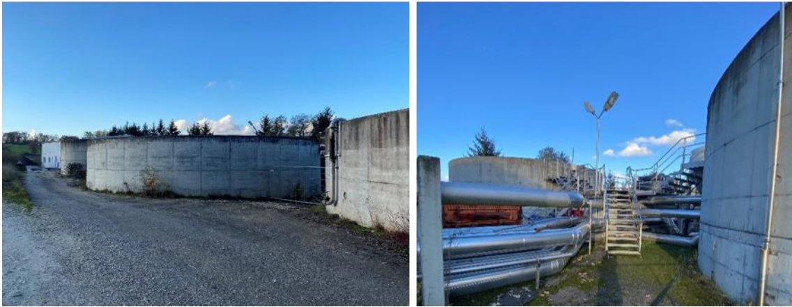
Abbildung 15: Stillliegende Kläranlage als mögliche Umbauoption für eine Biogasanlage
